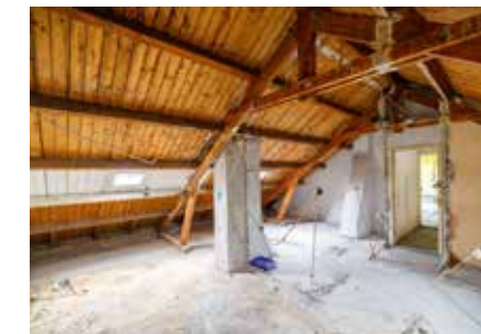
De ingang van de berging voor de renovatie.
