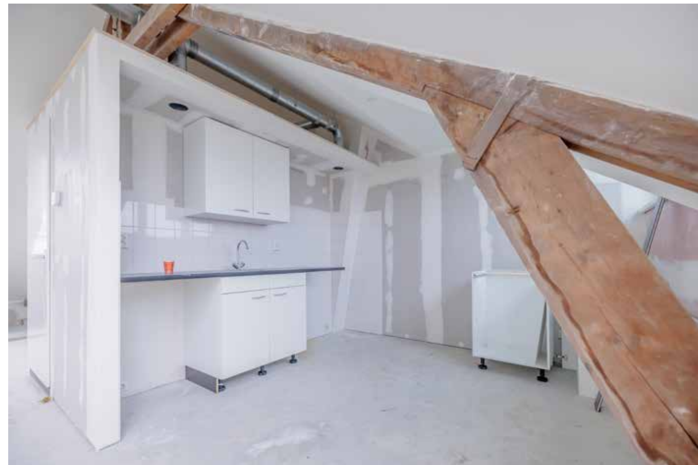
De houten balken zijn behouden, verder is alles nieuw.
