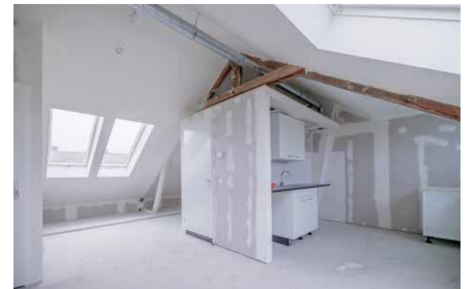
De nieuwe dakramen en de nieuwe keuken.
