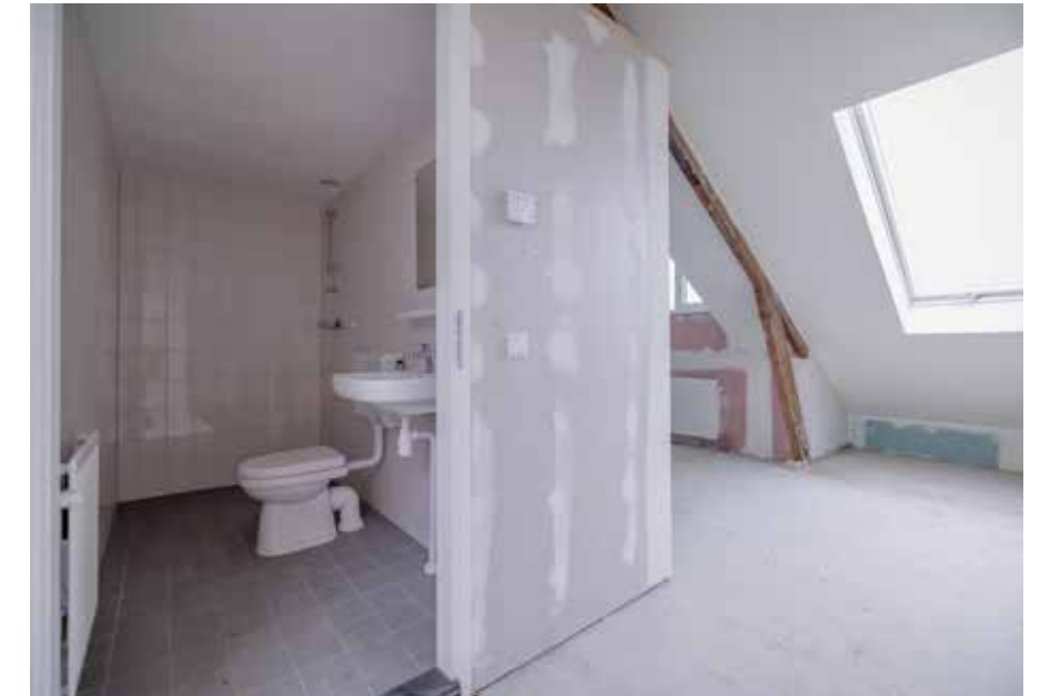
De binnenkant van de badkamer.
