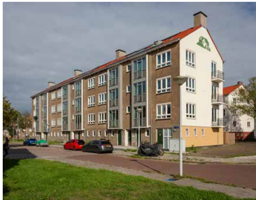
Dekker Kozijnprojecten leverde kozijnen, hsb-elementen en dakkapellen voor het project Hof van Descartes.
