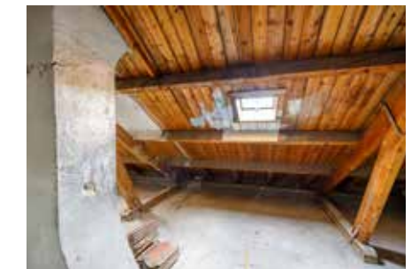
Het oude dakraam op de zolder.
