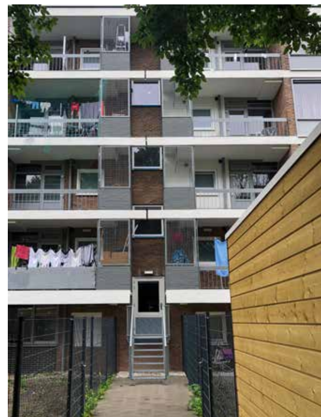
Aan de achterzijde werden koudebruggen geëlimineerd.
