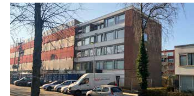
De voor- en zijgevels werden geïsoleerd en opgeknapt.
